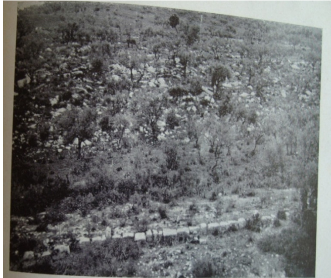
Cliche P. Salama Route de Guelma à HIPPONE dans sa montée au col de Fedjoudj Au 1 er plan la bordure en pierres de taille de la voie romaine En haut du cliché une ligne blanche et un poteau télégraphique indiquent le passage de la route nationale moderne
